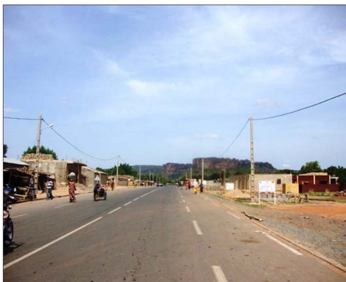
La route nationale n° 5 qui quitte Bamako pour aller jusqu'à la frontière de Guinée Conakry traverse le village de Siby. Les locaux de la COOPROKASI se trouvent au bord de cette route très passante.
